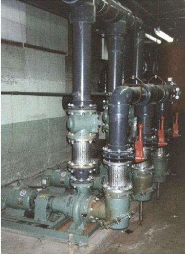
Figure 3. Effluent Pumps
